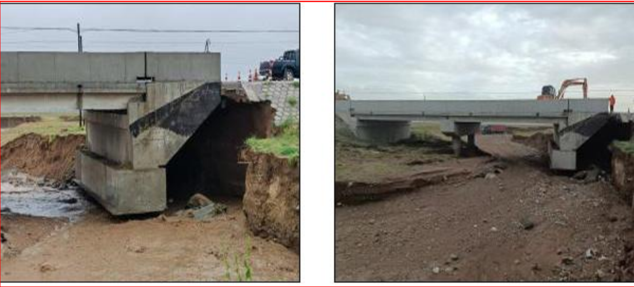
S311 线 29 号小桥(K215+454) 0#、2#桥台左右锥坡、溜坡及台背搭板下损毁情况
