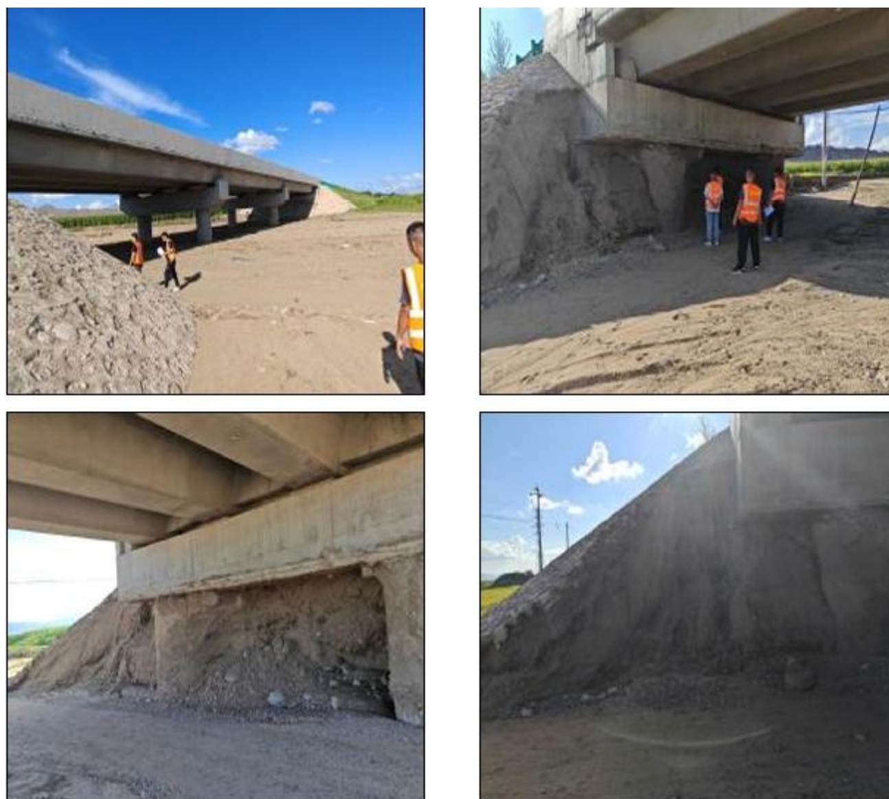
3#台锥坡、溜坡损毁;桩基础裸露
